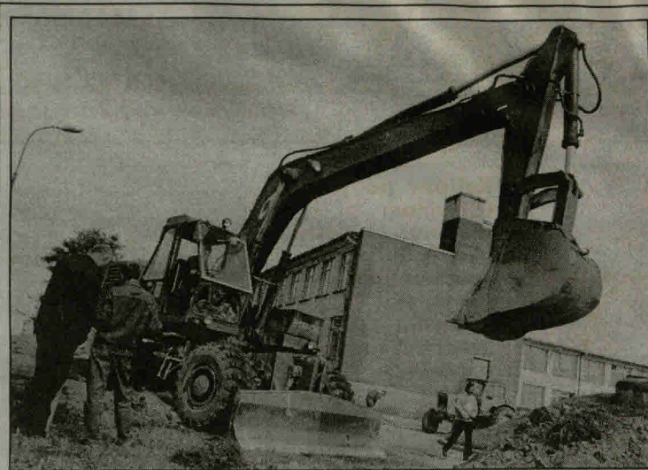
Bendrovės “Limega” darbininkai įrengimų statybos darbus pradėjo praėjusią savaitę. Jau nutiesta trasa, kuria tekės išvalytas vanduo. Vakar pradėta kasti duobės valymo įrengimams.
